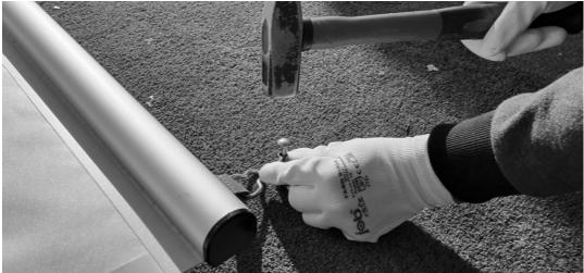
6. Die Schraube mit der Hand ausziehen und die Befestigung um die Schraube legen.
