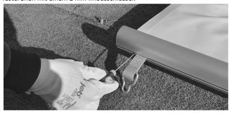
Das Bohren mit dem Ø 10 mm Bohrer, im Abstand 100 mm von der Abdeckung.
